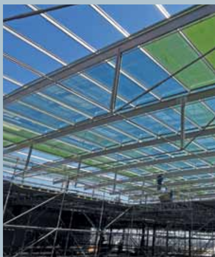
Энергоснабжение выставочного комплекса
