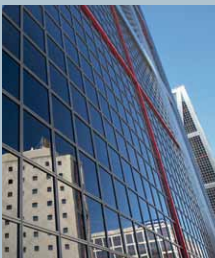
Надежное энергоснабжение компьютерного центра
