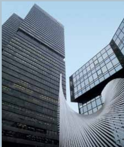
Бесперебойное снабжение высотных зданий
