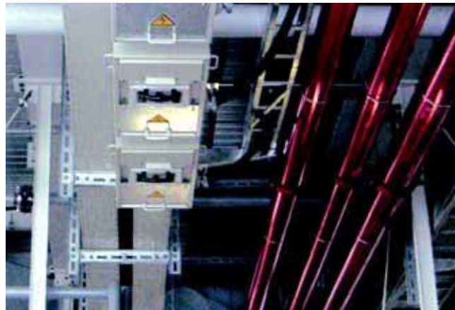
Низкая пожарная нагрузка распределительных шинопроводов
